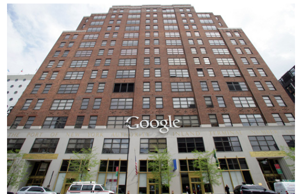
อาคารสำนักงานของกูเกิ้ลในมหานครนิวยอร์ก ที่ Port Authority building ชั้น 111
