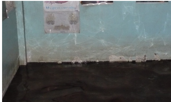
รูปที่ 5 ลักษณะของคราบบนผนังหลังน้ำท่วม
